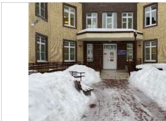
Фото №5 – Входная площадка главного входа. Главный вход.
