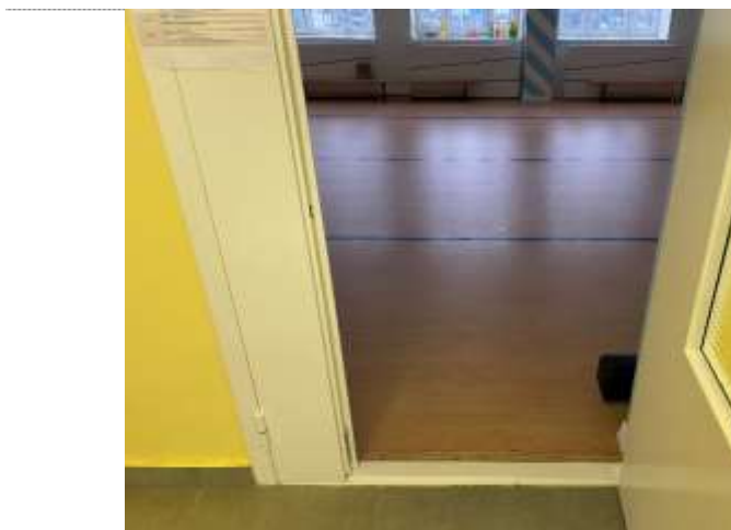
Фото №17 – Пути движения внутри здания (двери)
