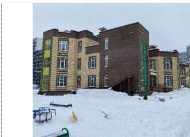
Фото №3 – Вход на прилегающую территорию.
