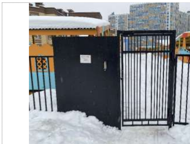
Фото №2 – Вход на прилегающую территорию.
