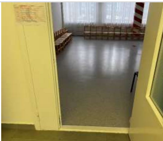
Фото №19 – Пути движения внутри здания (двери).
